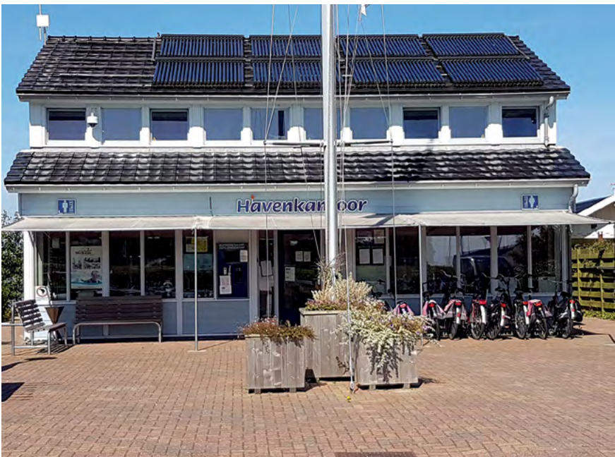
Das Hafenbüro im Hafen von Den Oever (Infos S. 48)
